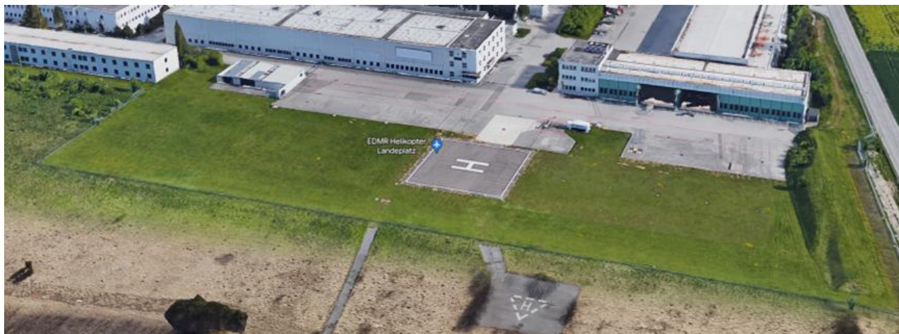
Figure 15. Airbus Ottobrunn Helipad, Munich, Germany
